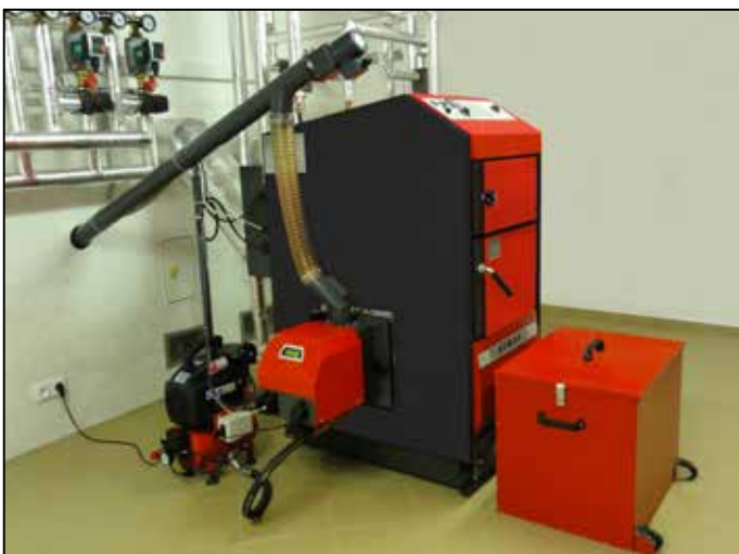
Příklad kotelny s kotlem D50P
